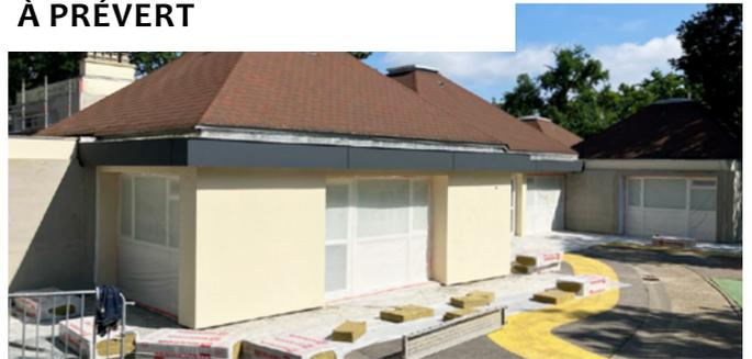
Grâce aux travaux d'isolation thermique réalisés sur l'ensemble de la **maternelle Prévert**, le bâtiment profitera au retour du froid de 16 % de déperdition de chaleur en moins, ce qui permettra aussi de faire de substantielles économies. Un visiophone conforme aux normes d'accessibilité a également été installé et l'aire de jeux dans la cour a été rénovée.
